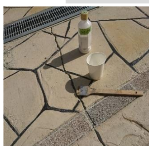
吸水調整 (ユニレックス1:4)
